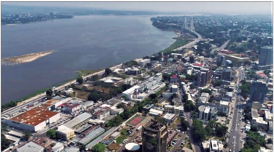
El río Congo a su paso entre Brazzaville y Kinshasa.
